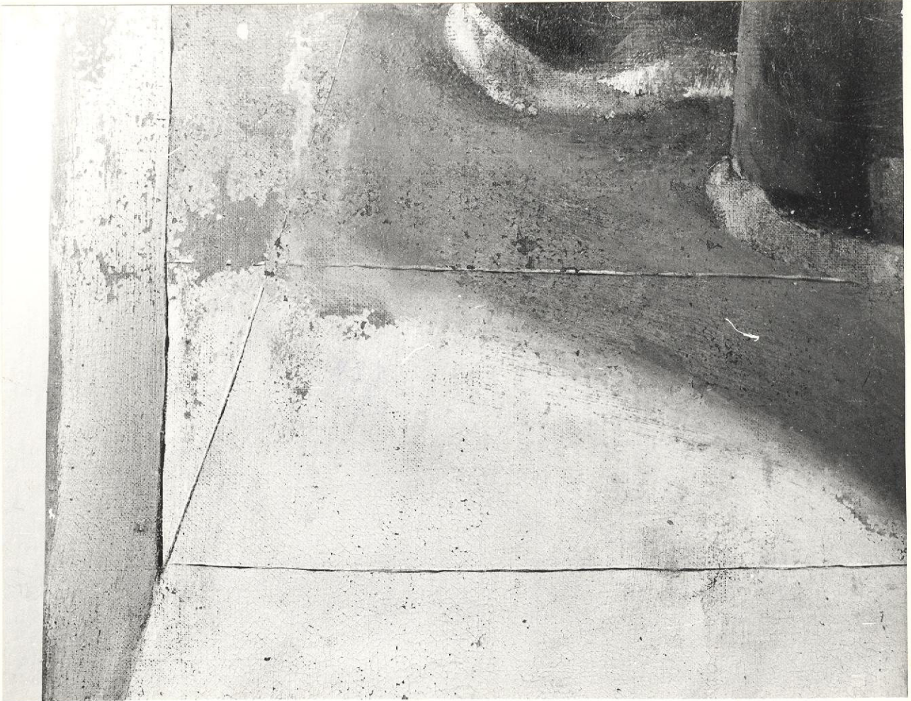
3 Detailaufnahme. Zustand während der Instandsetzung (Fehlstellen in originaler Farbschicht und Grundierung)
