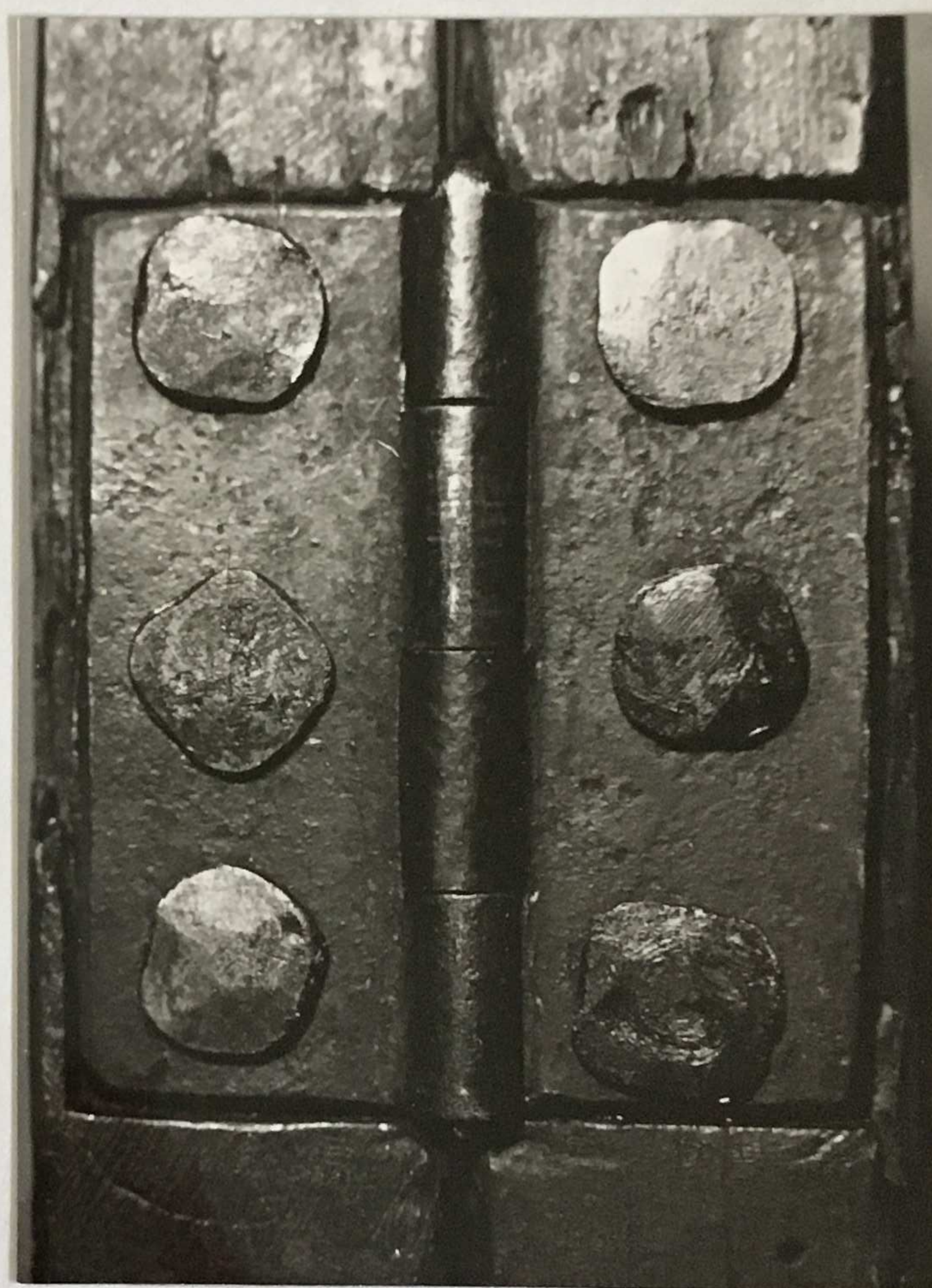
7 dito, nach erneuerter Nagelung
